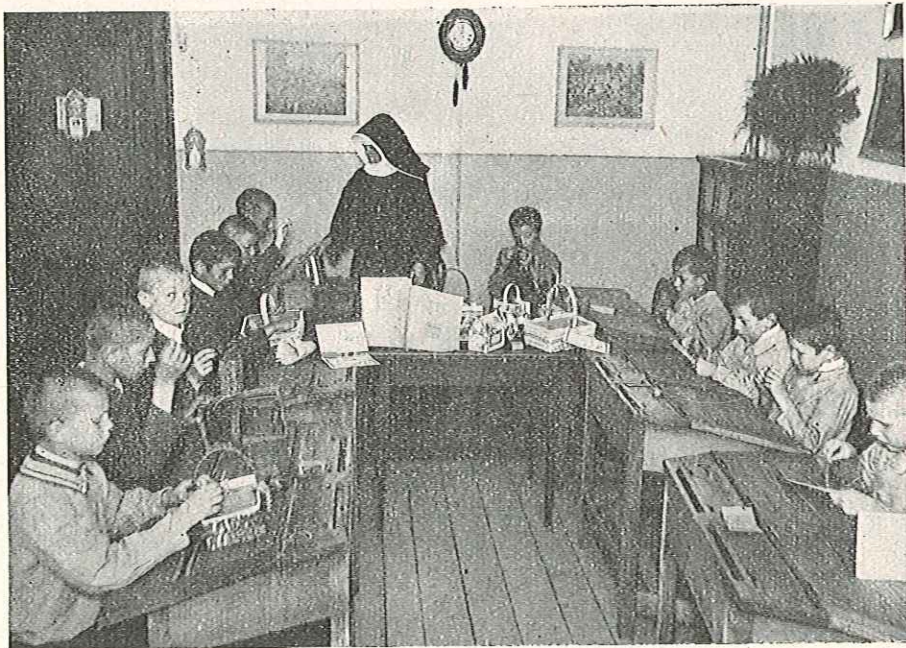
Knaben-Handfertigkeit in der Taubstummenanstalt Bremgarten.
